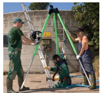
Einstieg ins Güllelager am Rettungsgurt mit einem umluftunabhängigen Frischluftgerät – gesichert durch zwei Personen.
